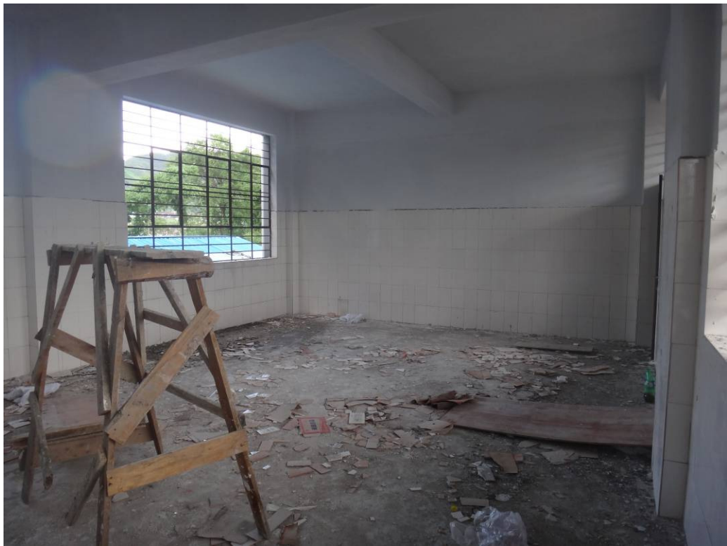
下允完小教学楼室内装修
